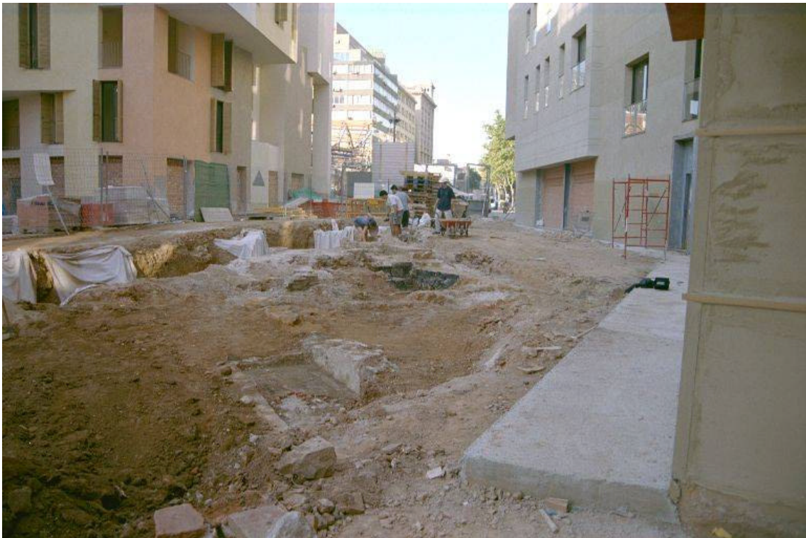
Foto núm.111 Fase III . Neteja inicial de les estructures de l'ampliació de la RSU
