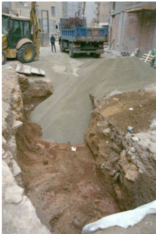
Foto núm.38 Fase I. Colamatació amb sauló de la rasa número 1
