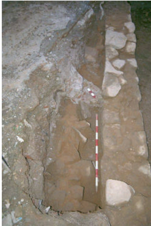
Foto núm.3 Fase I. Estat inicial dels murs, UE6, UE10 i UE17
