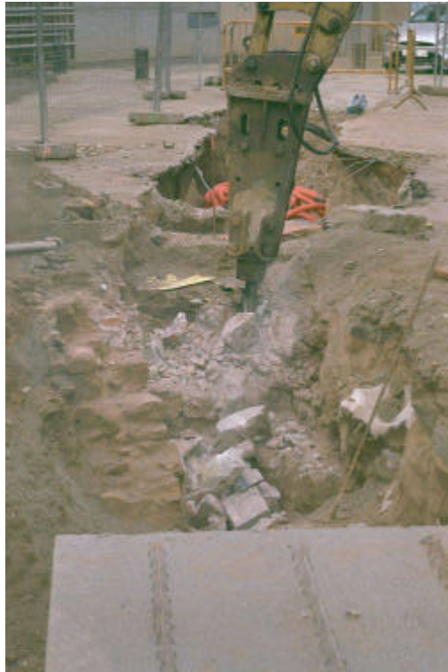
Foto núm.137 Fase III . Procés de desmuntatge dels murs UE173, UE175 i UE177
