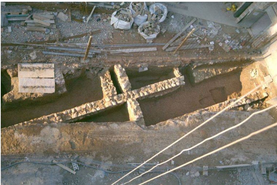
Foto núm.24 Fase I . Vista aèria de l'excavació, rasa número 1, cantó nord
