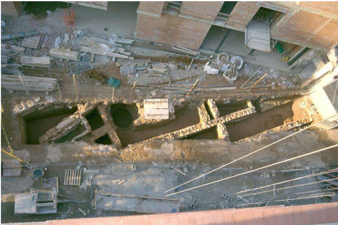
Foto núm.23 Fase I . Vista aèria de l'excavació, rasa número 1, cantó sud
