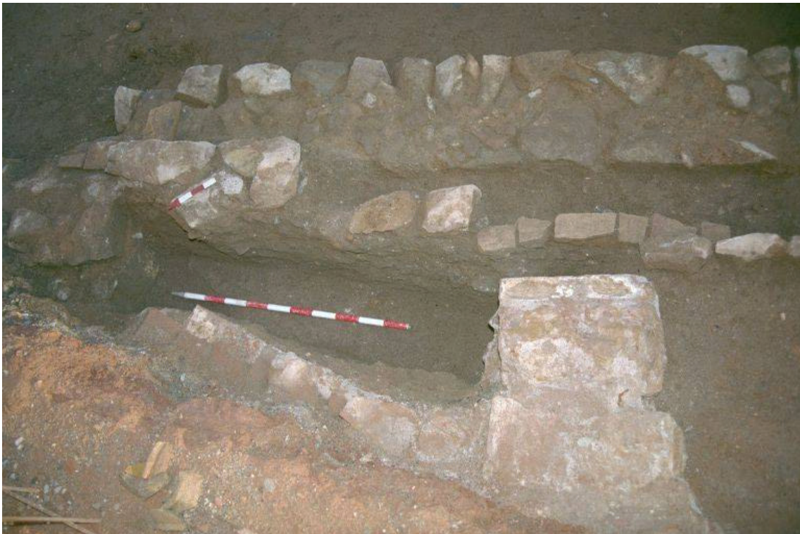
Foto núm.7 Fase I . Mur modern UE2 i claveguera moderna UE3. Vista parcial del mur UE5
