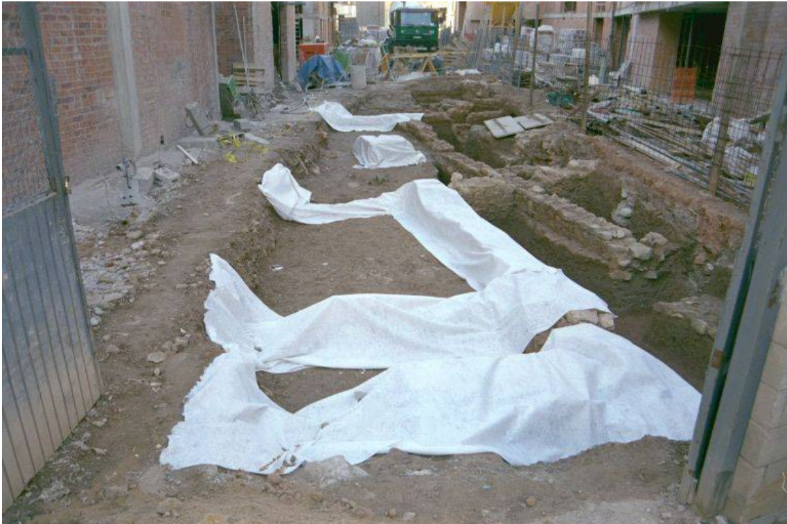
Foto núm.33 Fase I , ampliació RSU1. Protecció estructures
