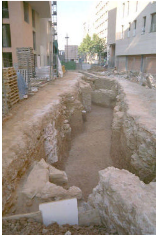
Foto núm.107 Fase II . Final de la rasa RSU2 des del nord
