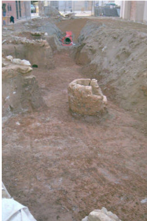
Foto núm.133 Fase III . Desmuntatge estructures de la RSU
