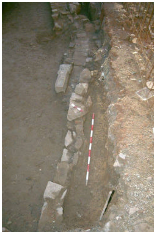
Foto núm.8 Fase I . Estat final de la claveguera moderna, UE3
